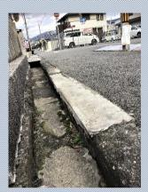
脆弱部の撤去→型枠設置→NAOS流し込み→硬化・解放
